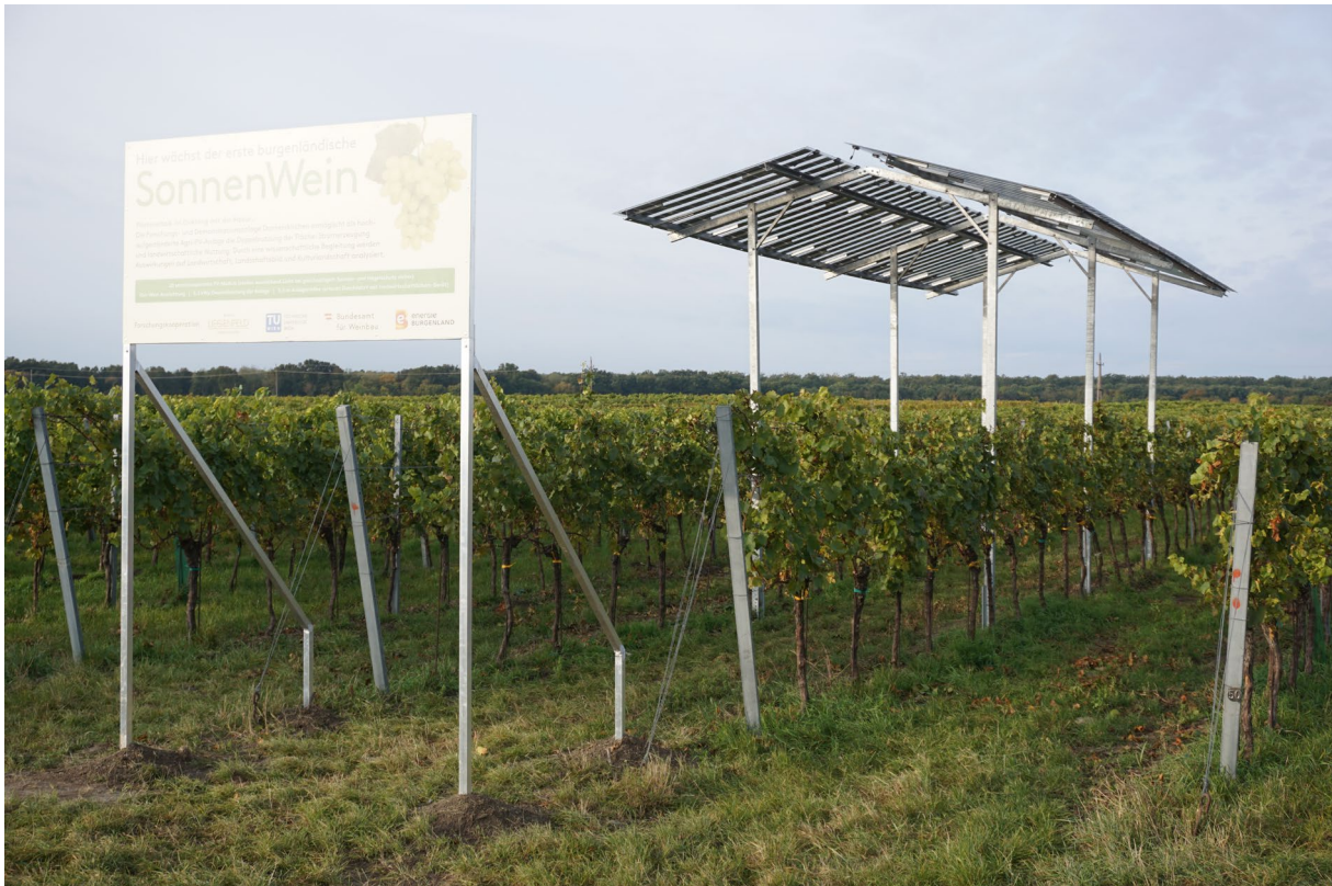
Abb. 1: Chardonnay-Weingarten in Donnerskirchen, teilweise von einer Photovoltaik-Anlage beschattet.
