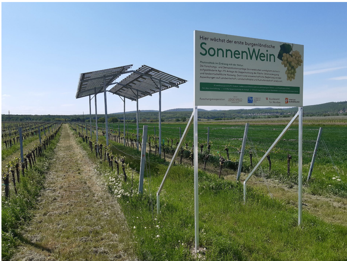
Abb. 6: Chardonnay-Weingarten in Donnerskirchen, teilweise von einer Photovoltaik-Anlage beschattet.
